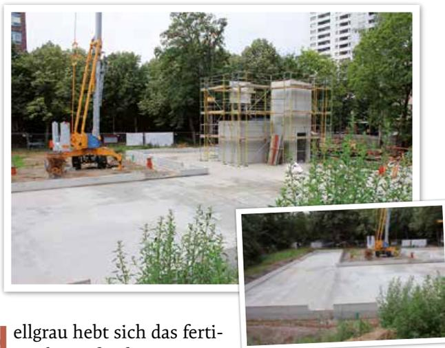
Hellgrau hebt sich das fertige Plattenfundament vom umgebenden Erdreich ab. Deutlich ist der U-förmige Grundriss des neuen Gemeindezentrums zu erkennen. Als erste Gebäudeteile ragen der Aufzugsschacht und der angrenzende Technikraum hervor, beide aus Stahlbeton gefertigt, um die notwendige Tragfähigkeit und Brandsicherheit zu gewährleisten. Rund um das Plattenfundament erhebt sich die Sockelaufkantung aus Stahlbeton, auf der die Außenwände errichtet werden.
